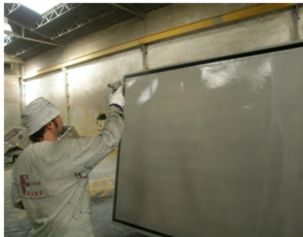
Aplicación por aspersión de aire de CorrosionGard-160S
